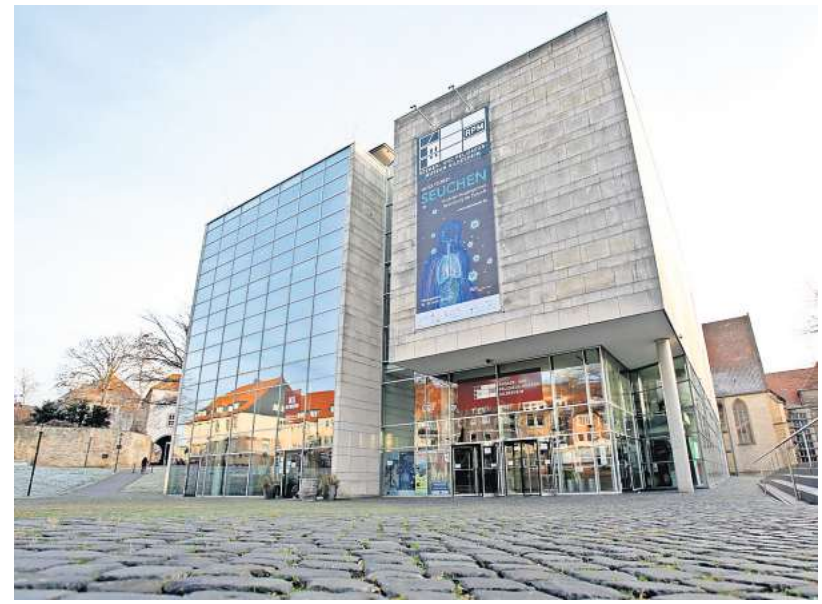
Lüftungs- und Klimaanlage stehen auf der To-do-Liste des Roemer-Pelizaeus-Museums.
