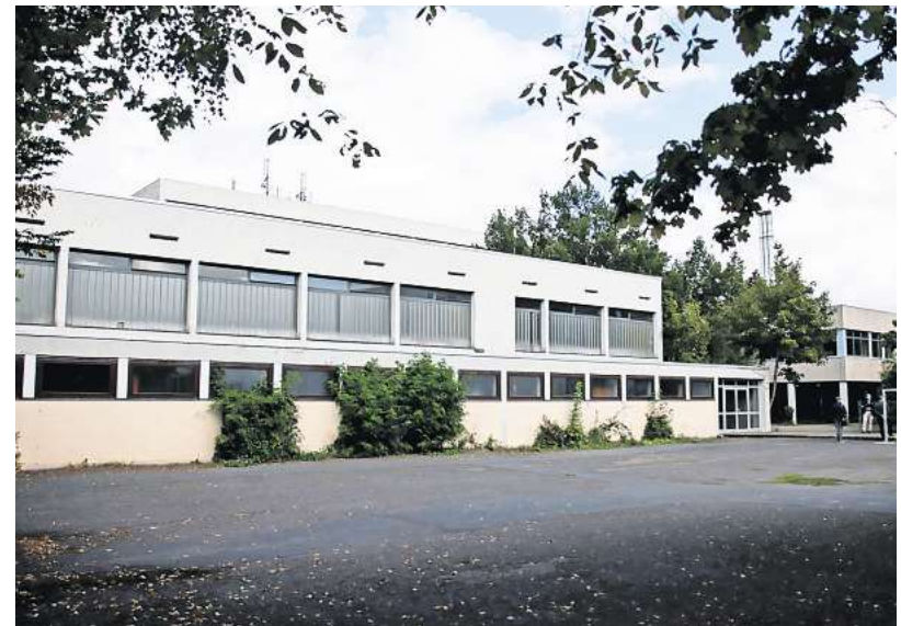
In der Sporthalle der Robert-Bosch-Gesamtschule machen unter anderem das Dach und die Gebäudehülle Probleme.
