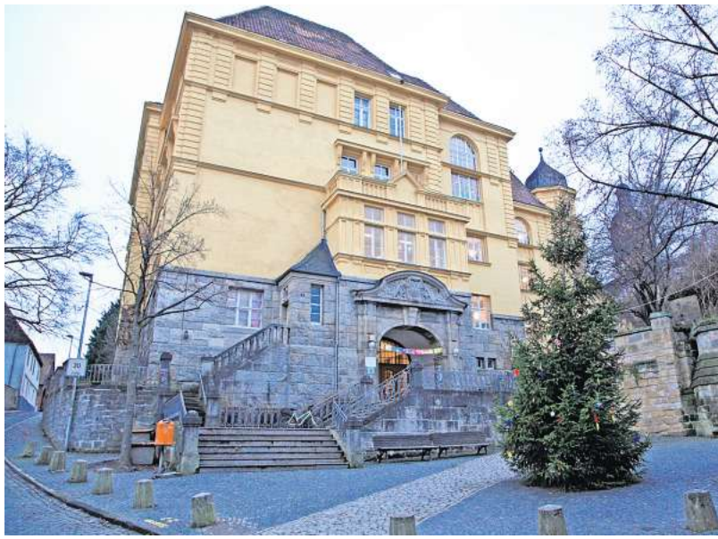
Fenster, Leitungen und Türen müssten in der Gelben Schule saniert werden.
